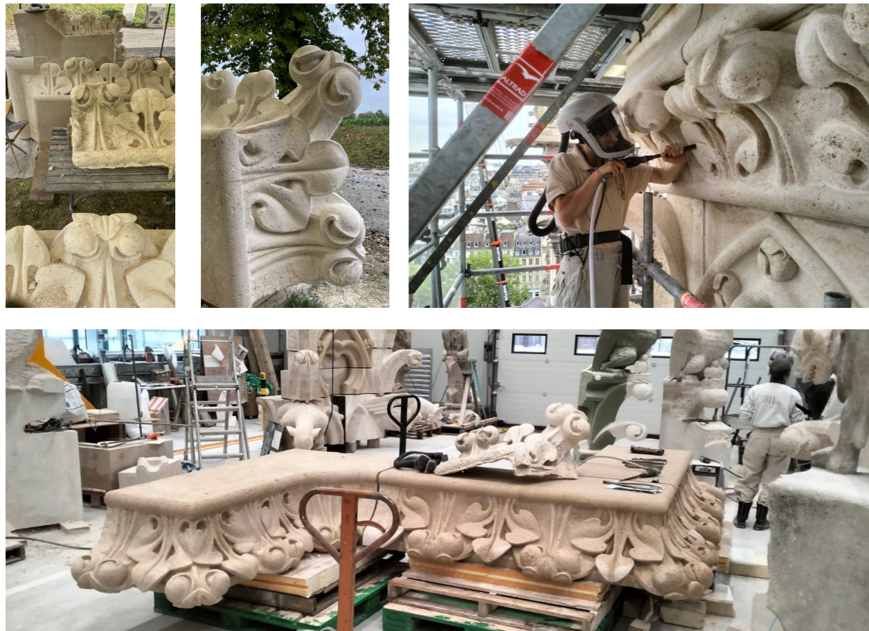
Restitution de frises de crochets de la cathédrale Notre-Dame de Paris. Modelés et finitions pour L'Atelier de la Pierre, sous-traitant de Tollis, 2023-2024.
