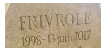
Restauration d'une stèle : nettoyage du socle et de la plaque funéraire, restitution en marbre, d'une partie cassée du socle, collage, regravure des inscriptions qui seront ensuite dorées, 2021.
