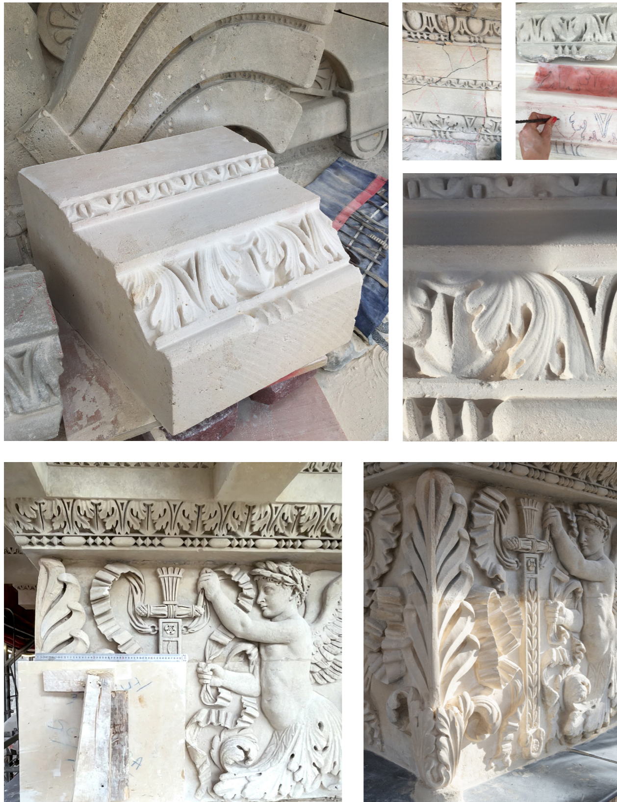
Restauration du fronton de la façade Nord du Palais Bourbon, Assemblée Nationale, Paris, Entreprise SCULPTURA, 2022.
