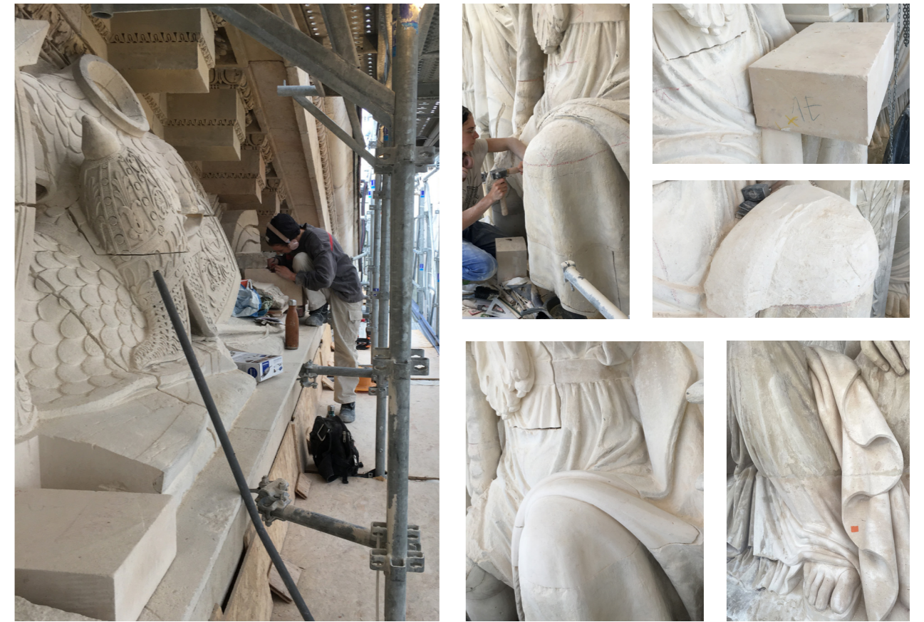
Restauration du fronton de la façade Nord du Palais Bourbon, Assemblée Nationale, Paris, Entreprise SCULPTURA, 2022 Refouillage et restitution de blocs sculptés altérés tels que des attributs, casque, carquois, balance, pieds, mains, genoux, drapés. Ragréage de sculpture et ragréage de joints.
